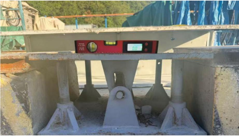
图 4.3-7 调坡器及数显坡度仪配合使用
