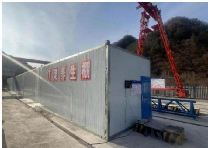
图 4.3-9 移动装配式养生棚端头节段
