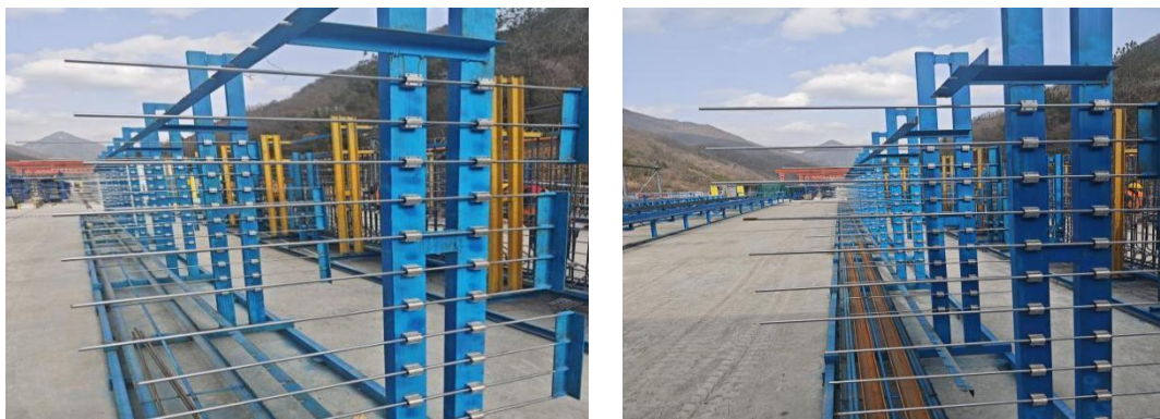
图 4.3-3 阻尼滑块钢筋绑扎胎架
