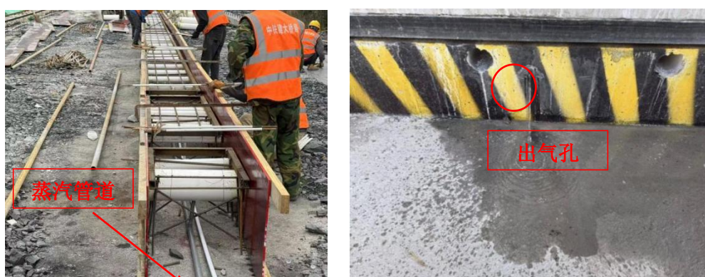
图 4.3-8 蒸汽管道预埋
