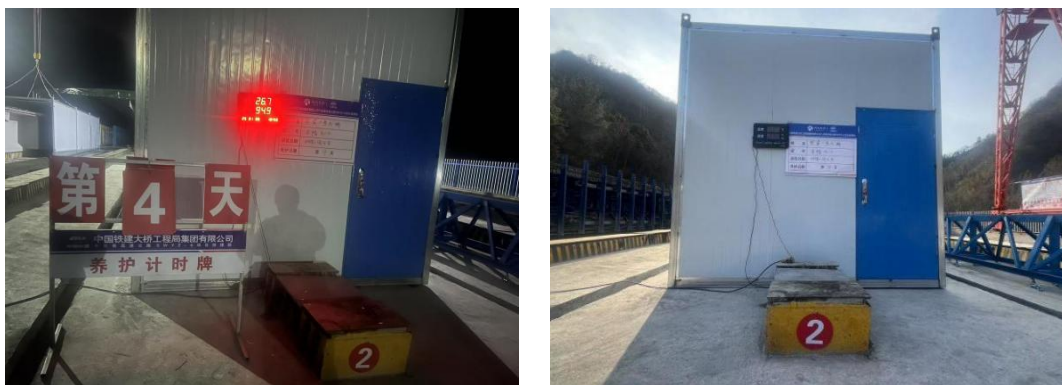
图 5.7-3 梁板蒸养温度控制
