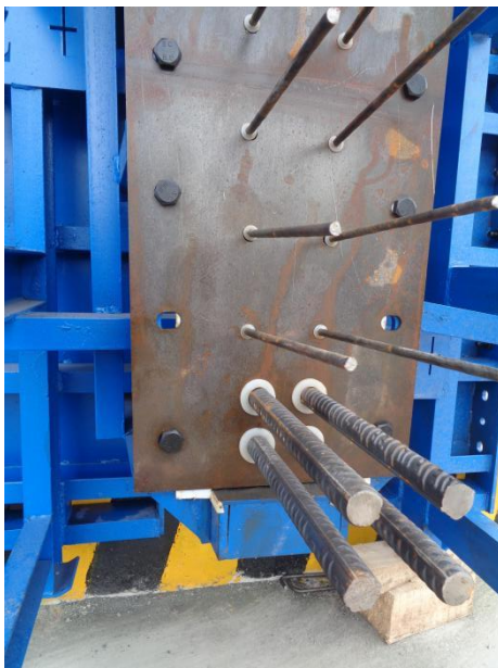
图 5.5-6 横隔梁橡胶止浆圈安装实物效果
