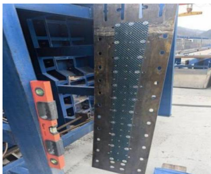
图 5.5-4 横隔梁止浆带安装
