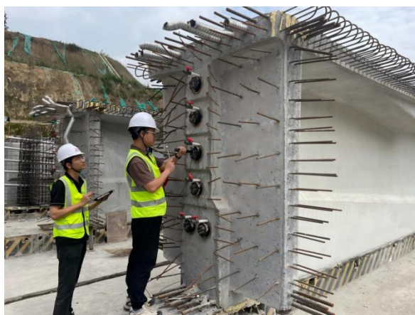
图 5.8-4 孔道压浆密实性检测
