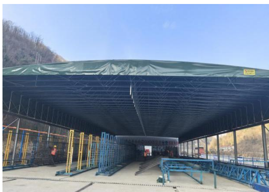
图 4.3-2 电动伸缩式防护棚
