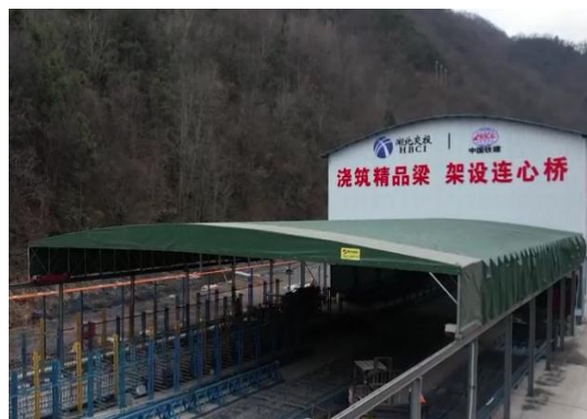
图 4.3-2 电动伸缩式防护棚
