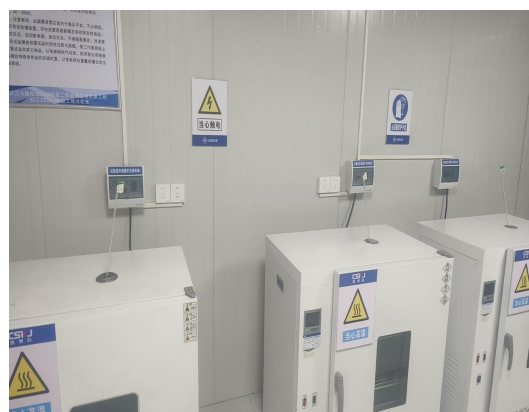
电气开关安装
