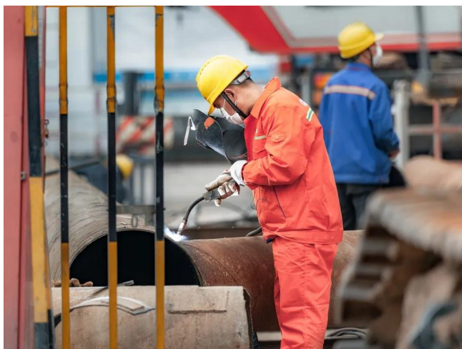
鳊鱼洲长江大桥焊接施工。黄丽霞 供图
