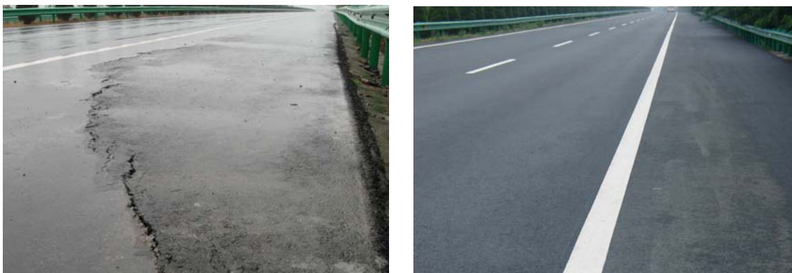
图5 施工前（左）与施工一年后路面实际情况对比
