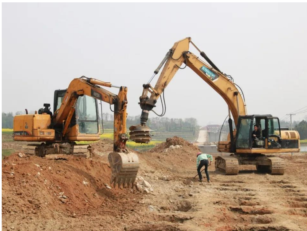
黄黄铁路路基土石方施工。中铁四局 供图
