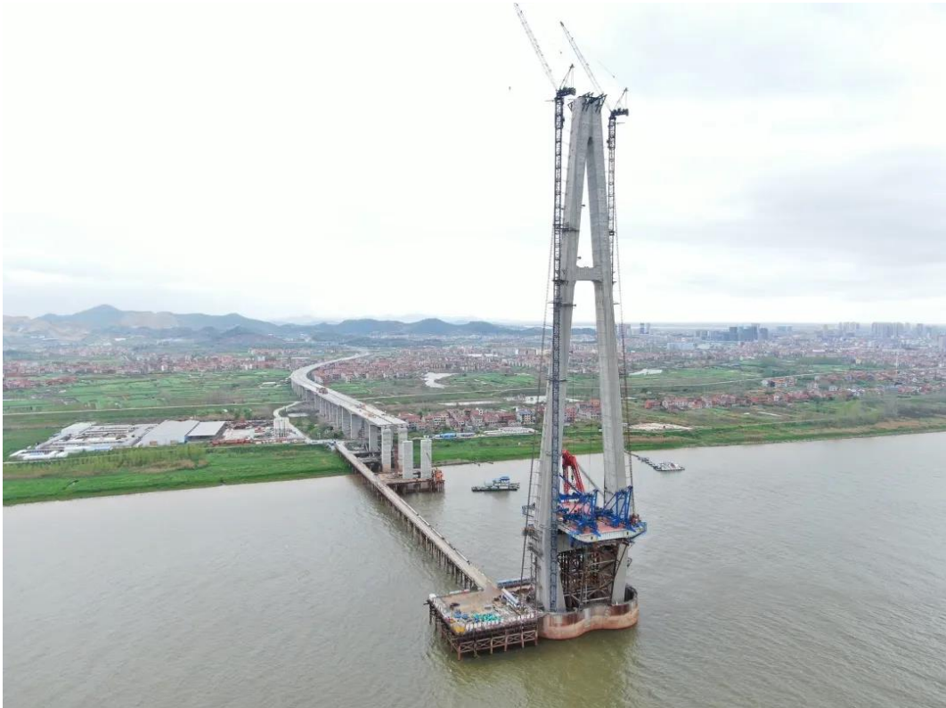
武穴长江大桥将采用桥面吊机架设剩余52片钢箱梁。黄马杰 摄
