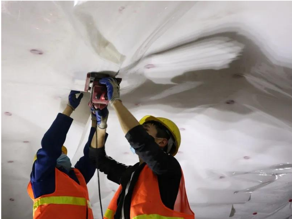
黄黄铁路铁家冲一号隧道止水带施工。中铁四局 供图
