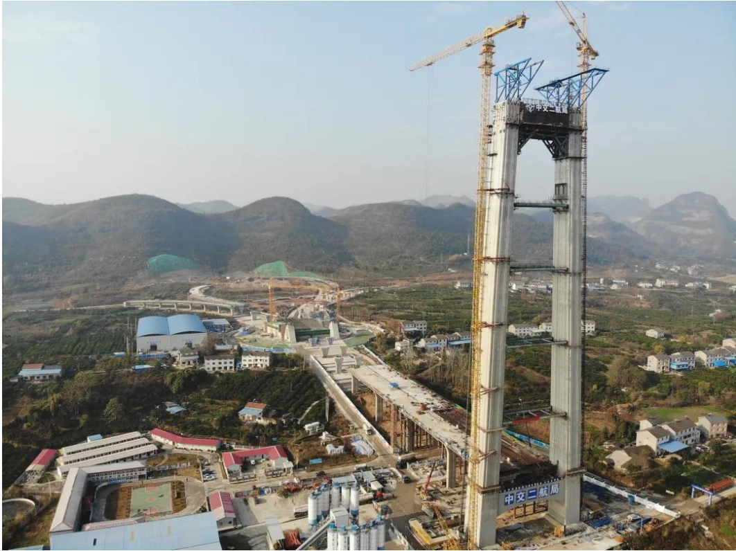
3月24日，伍家岗长江大桥作为宜昌城区首批重点示范项目正式复工复产，人员返岗率达90%。 中交二航局 供图
